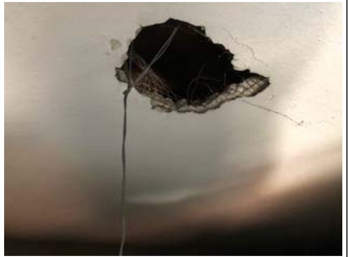
Particolare solaio copertura lignea
