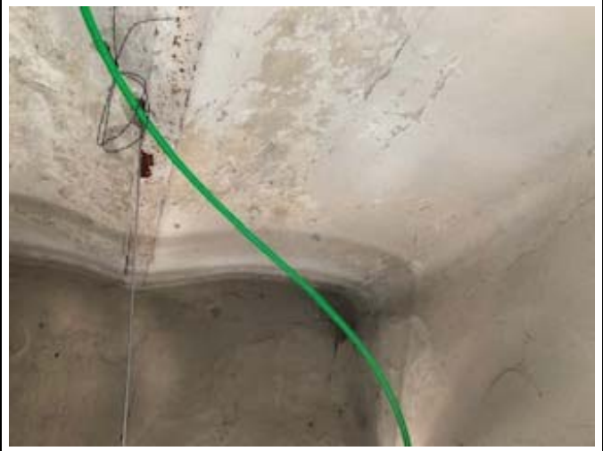
Piano terra – zona bagni con voltine
