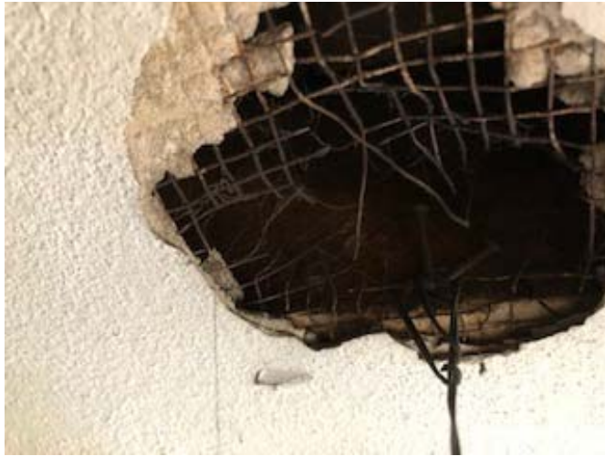
Particolare solaio copertura lignea
