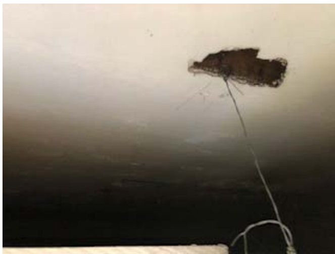
Particolare solaio copertura lignea
