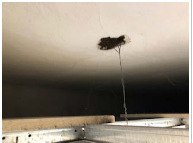
Particolare solaio copertura lignea
